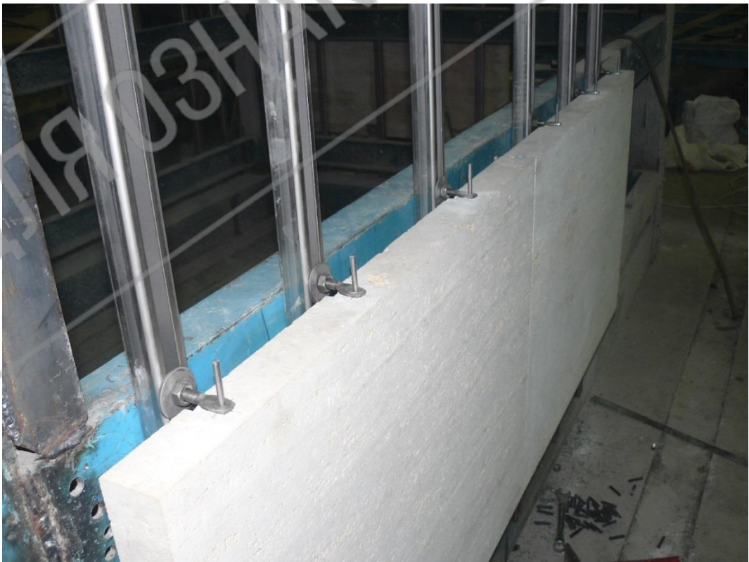
Рис. 4.8. Конструкция крепления панелей
