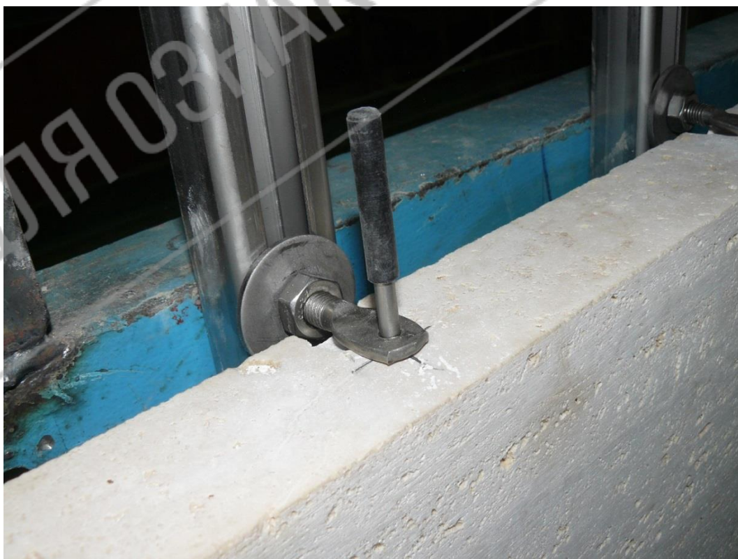
Рис. 4.7.Общий вид стержня с нейлоновой трубкой до установки нижней (а) и верхней (б) панелей
